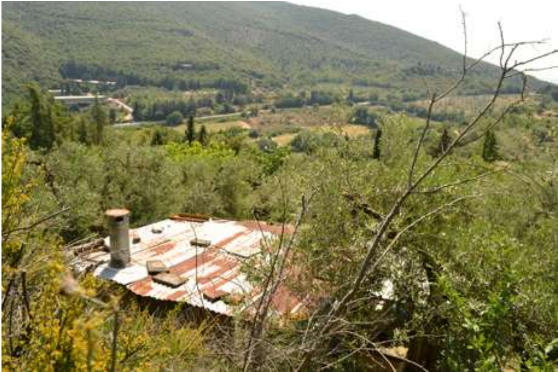
Figura 12 - Detrattore abientale – Corciano
